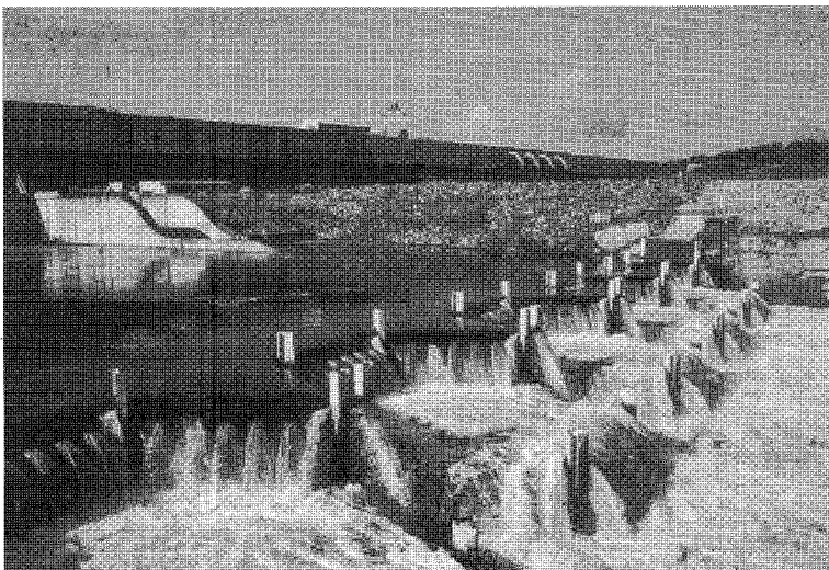
Figure 6 Seuil à lames déversantes dans sa configuration initiale. Aerating weir in the initial configuration.
